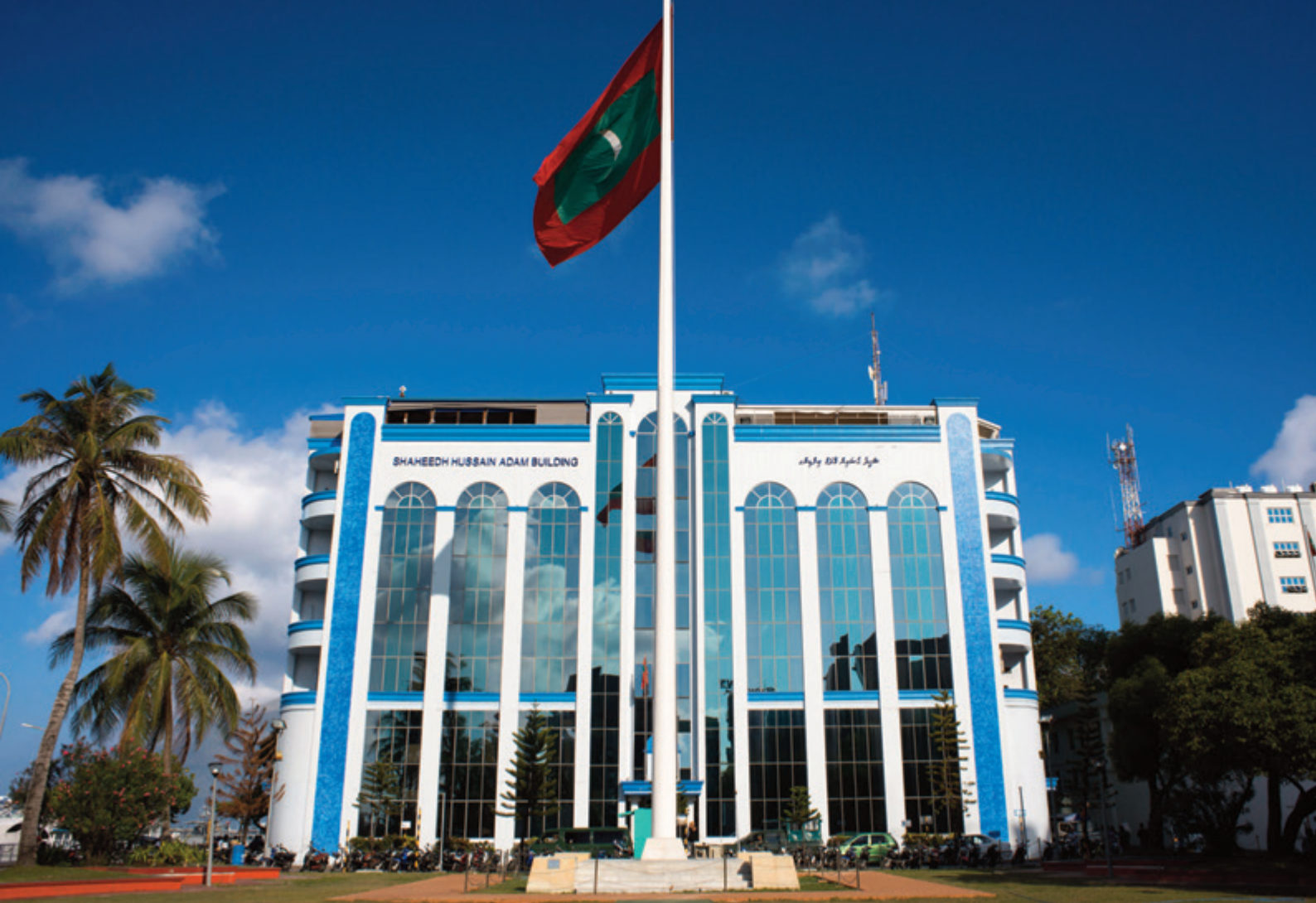
Shaheed Hussain Adam Building, el edificio de la Comisaría general de policía
