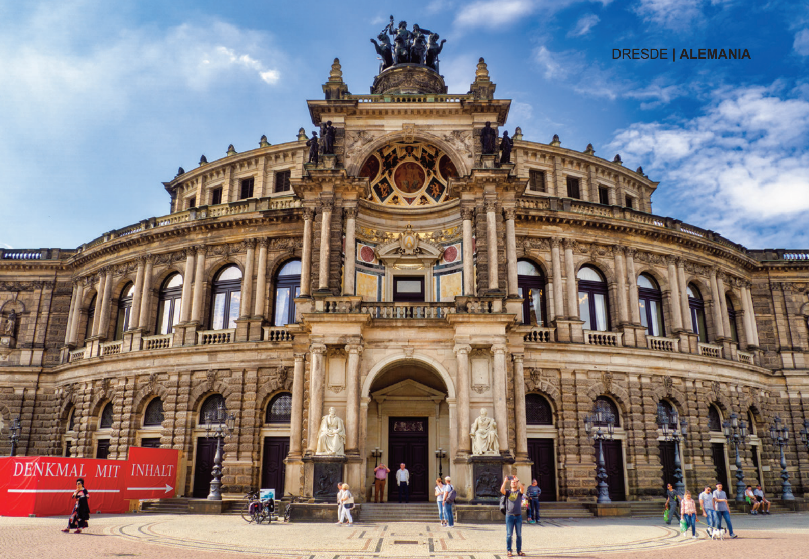
Edificio del Theaterplatz.
