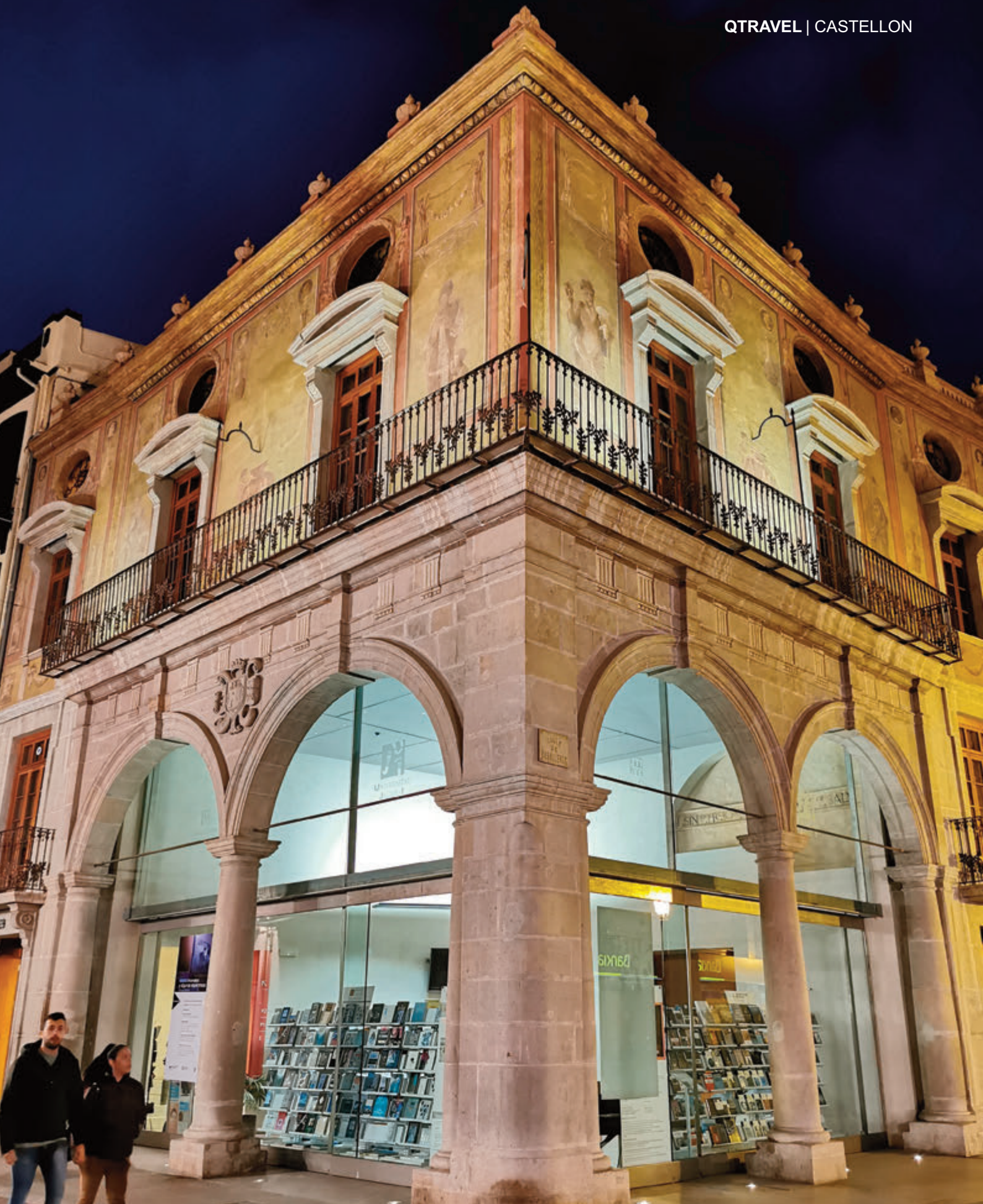
EDIFICIO DE LA ANTIGUA LONJA DEL CÁÑAMO EN CASTELLÓN DEL SIGLO XVII
