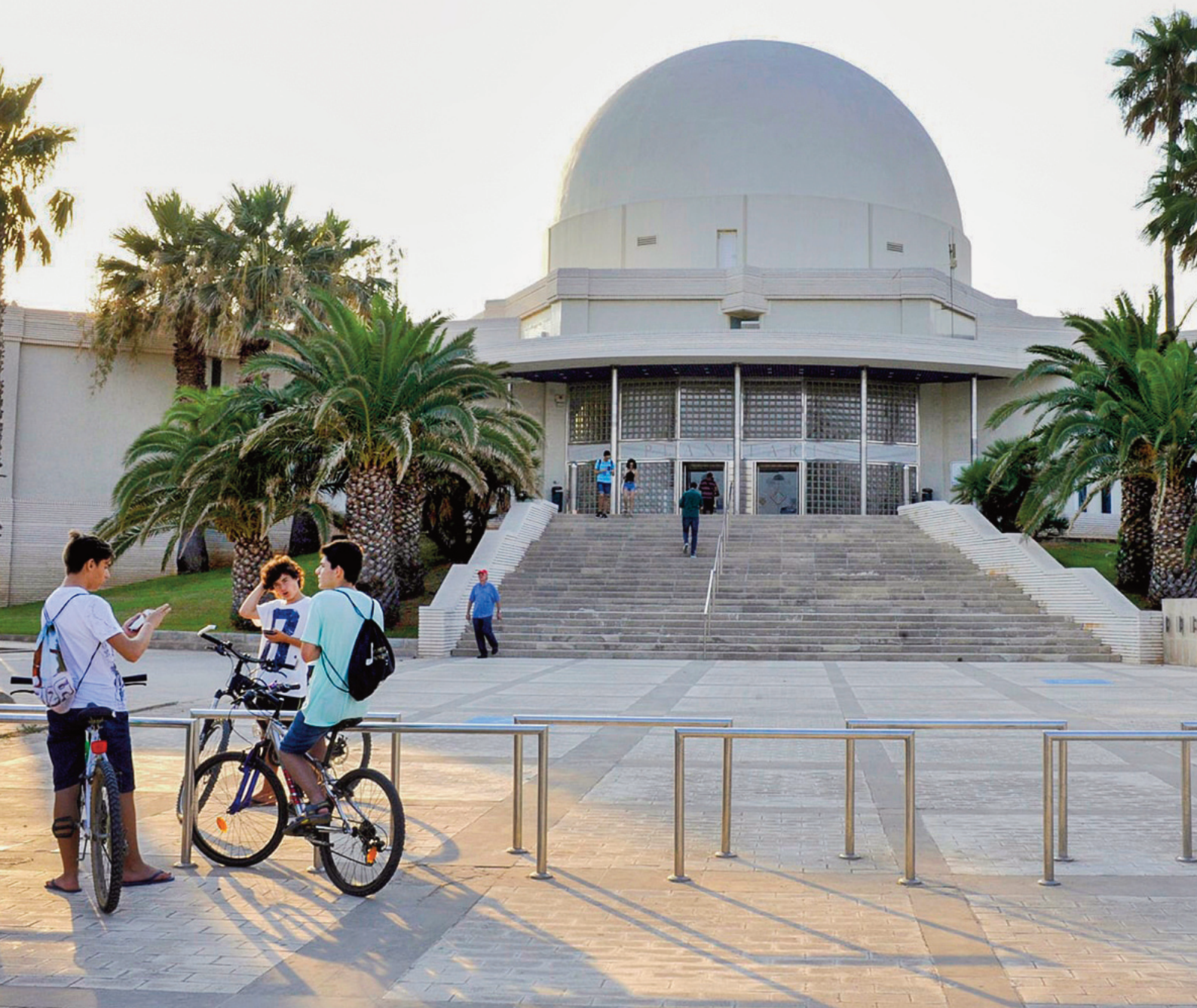
Edificio del Planetario de Castellón en el Grao.
