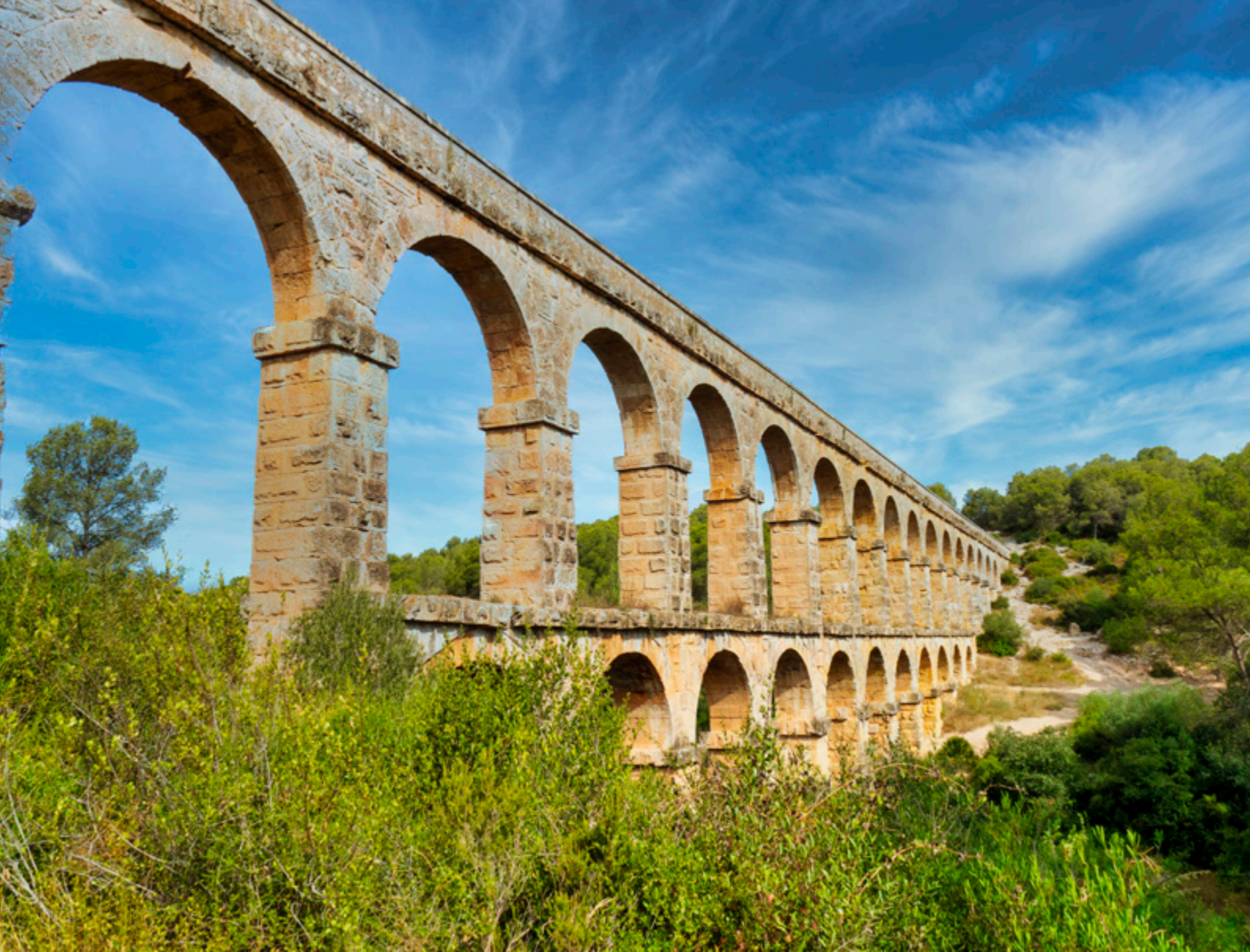
Acueducto de las Ferreres, también conocido como el "Puente del Diablo".
