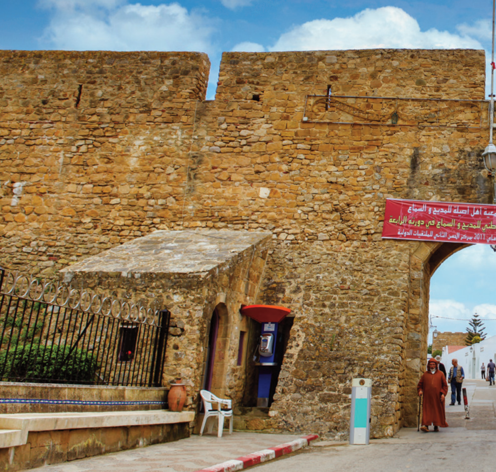
Puerta de acceso interior desde la muralla de defensa de Asilah.
