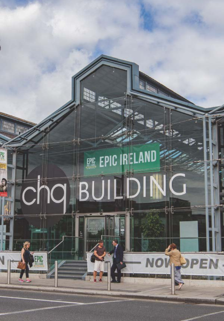
Exterior del chq Building que alberga el museo Epic Ireland.
