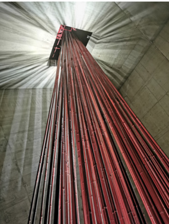
Interior del pilar 7 del Puente 25 de Abril. Derecha: Exterior del puente.
