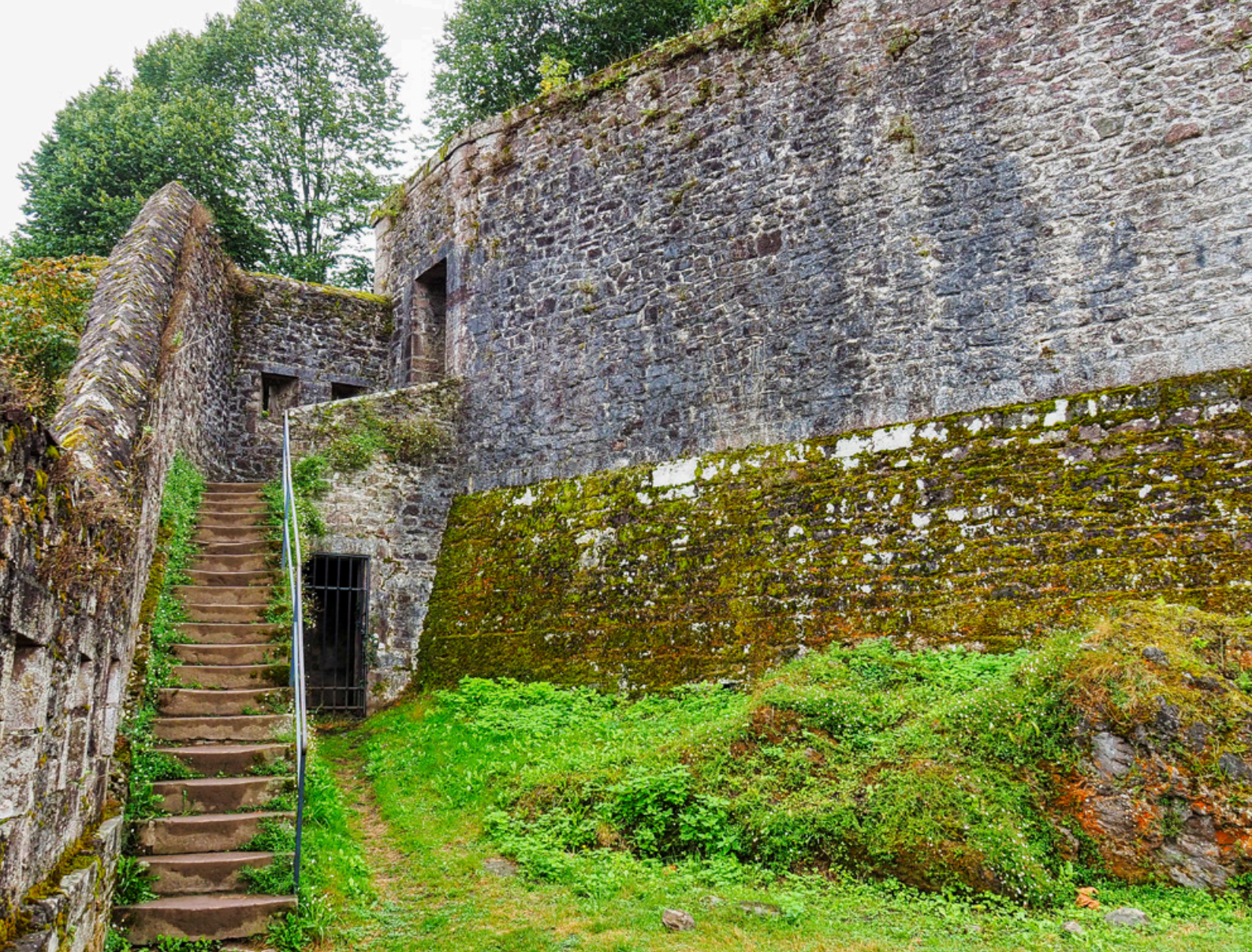
Escalinata del Camino de Ronda y polvorines en la Ciudadela de Mendiguren
