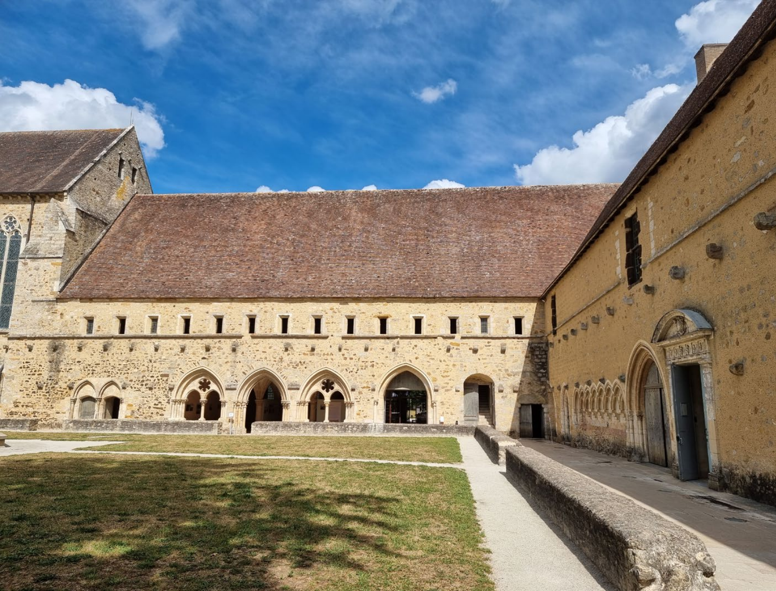
Patio interior de acceso a la Abadía Real de Épau.
