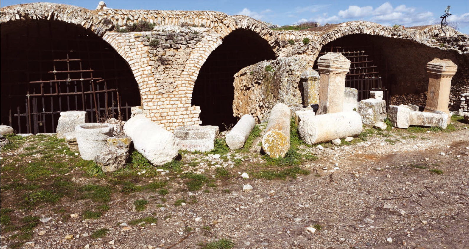
Conjunto de cisternas de agua potable.
