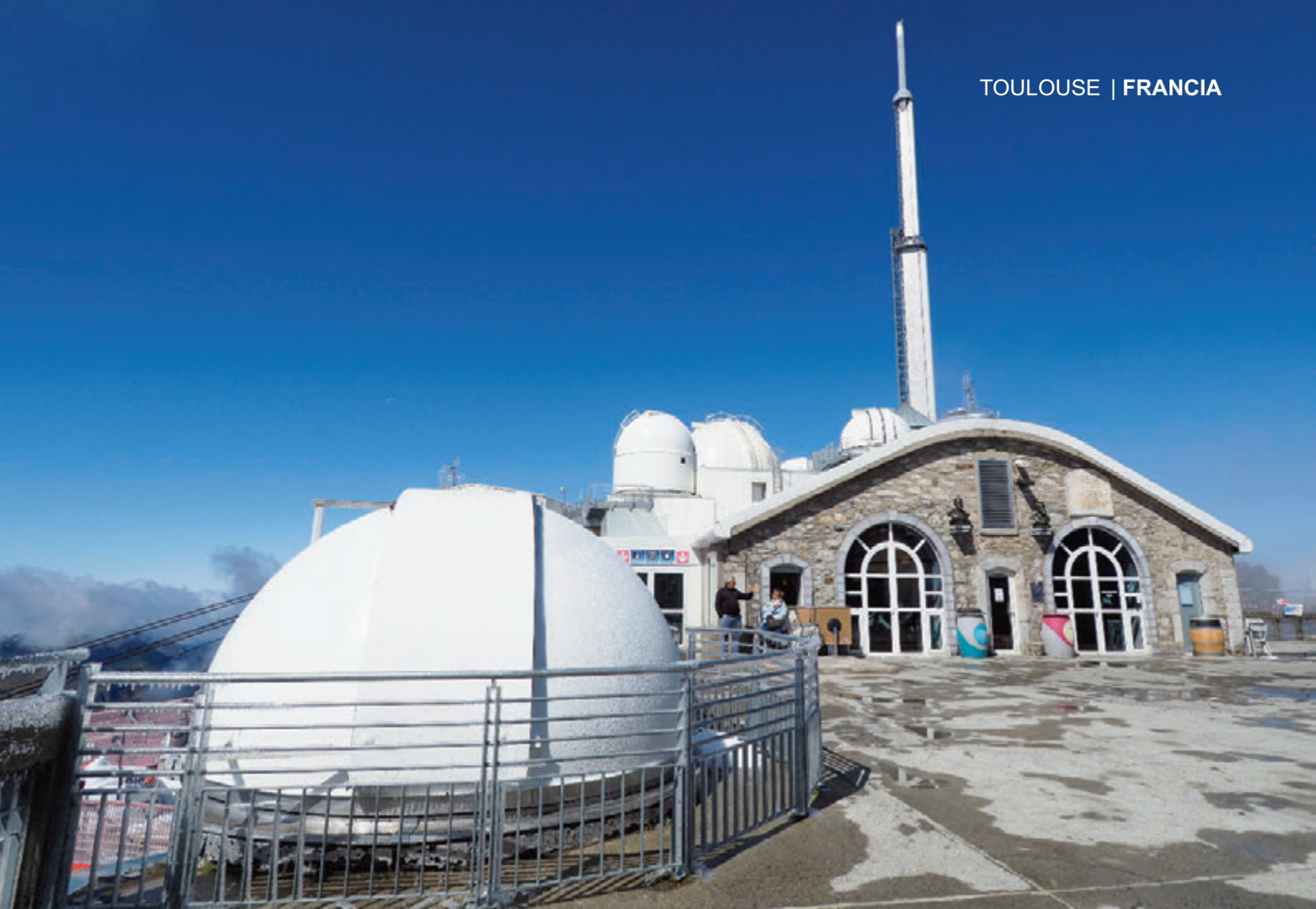
Instalaciones principales del Pic du Midi.
